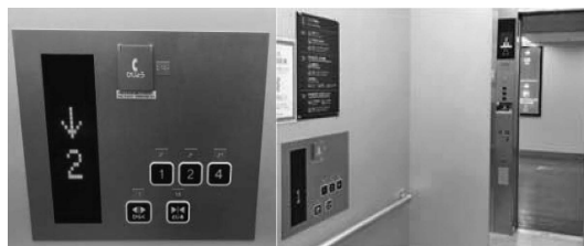
圖 6 無障礙電梯設置
