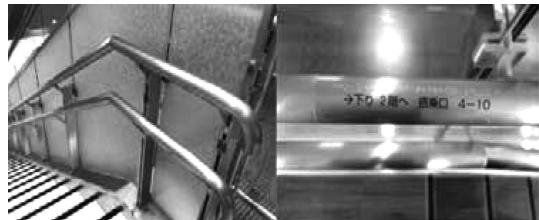
圖 5 階梯扶手設置
